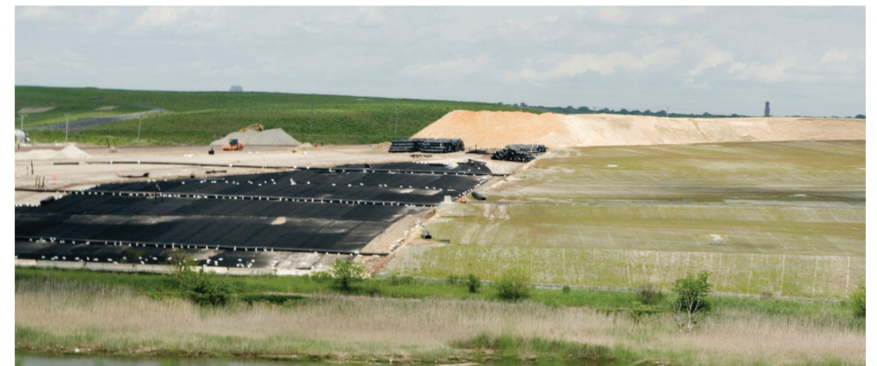
Fig. 28. Relleno sanitario siendo cubierto. Fuente: http://timeline.freshkillspark.org Accedido el 20-07-201
