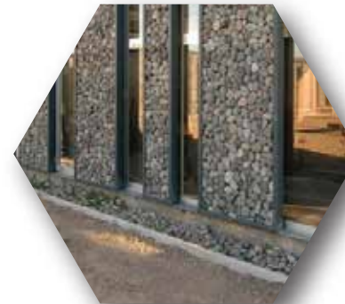
MARCOS METÁLICOS CON GAVIÓN DE PIEDRA
