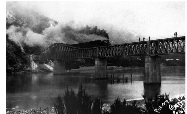
Locomotora sobre puente Banco de Arena 1916. Fuente: Biblioteca Nacional de Chile.
