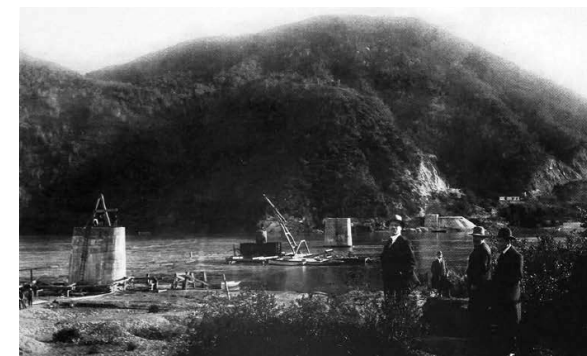
Vista de la construcción del Puente Banco de Arena, 1910. Fuente: Memoria Chilena.
