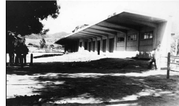
Vista andén estación de Constitución. Fuente: Memoria Chilena.
