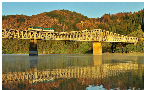
Buscarril sobre puente Banco de Arena. Fuente: Revista Enfoque.
