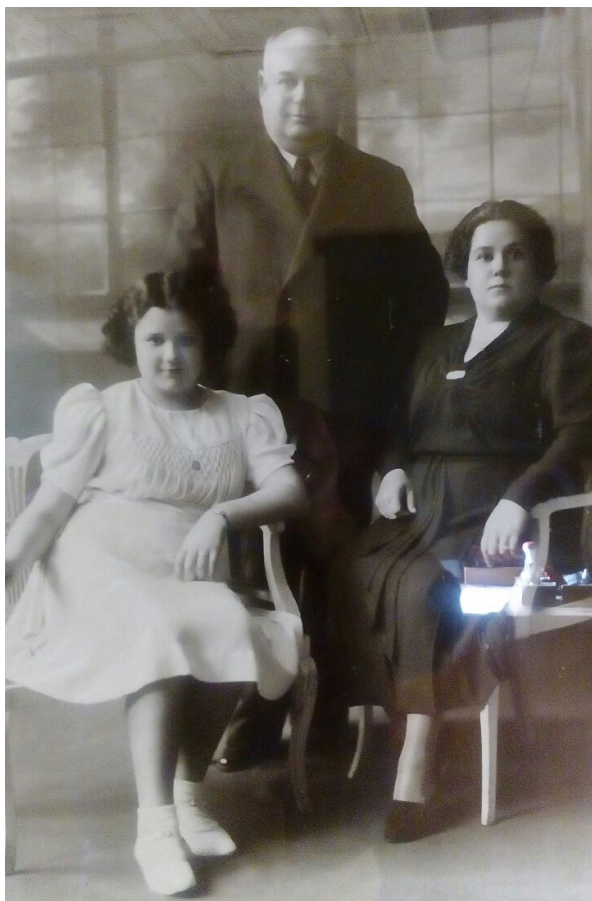
Figura 3.14.: Federico Costa, su esposa María Chuminatto y su hija Fuente: Fotografía facilitada por personal de seguridad de la fábrica
