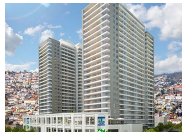
Figura 3.4: Construcción de dos torres en ex edificio Chiletabacos Fuente: Recuperado el 20 de mayo , 2018, desde http://www.elmartutino.cl/noticia/sociedad/foto-construiran-dos-torres-de-25-pisos-en-el-ex-edificio-chiletabacos-en-valparaiso
