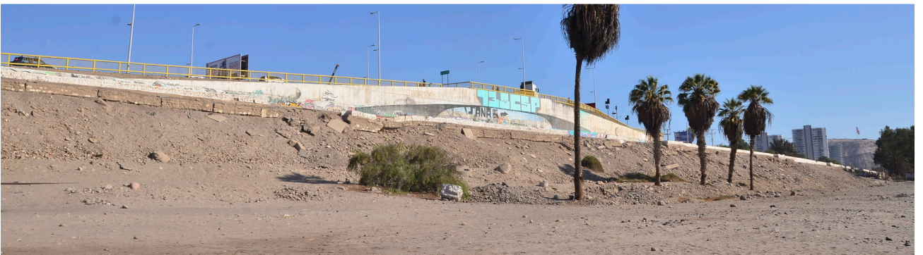
Sector en abandono, Playa Chinchorro. Fuente: Elaboración Propia
