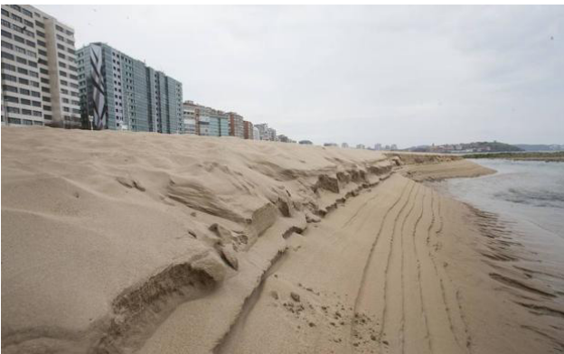
Recuperación Arena Borde Costero. Fuente: Elaboración Propia
