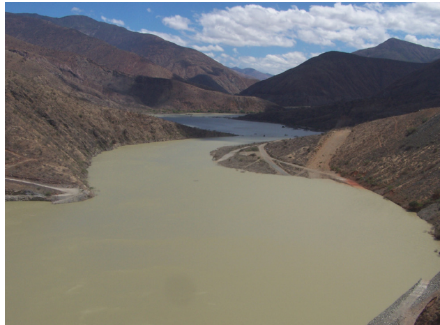
Colmatación Embalse Limón. Fuente: Odebrecht
