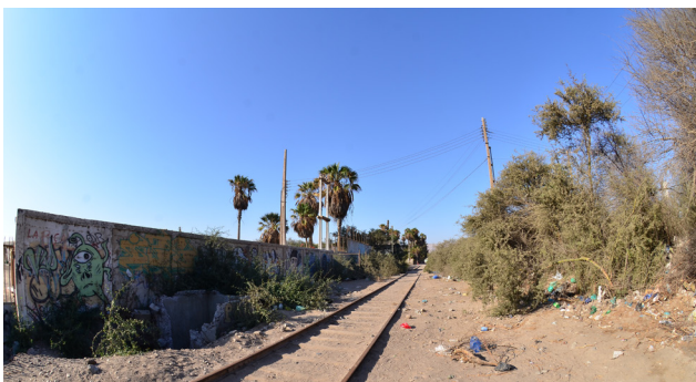
Vista Ferrocarril Tacna - Arica, sector desembocadura. Fuente: Elaboración Propia
