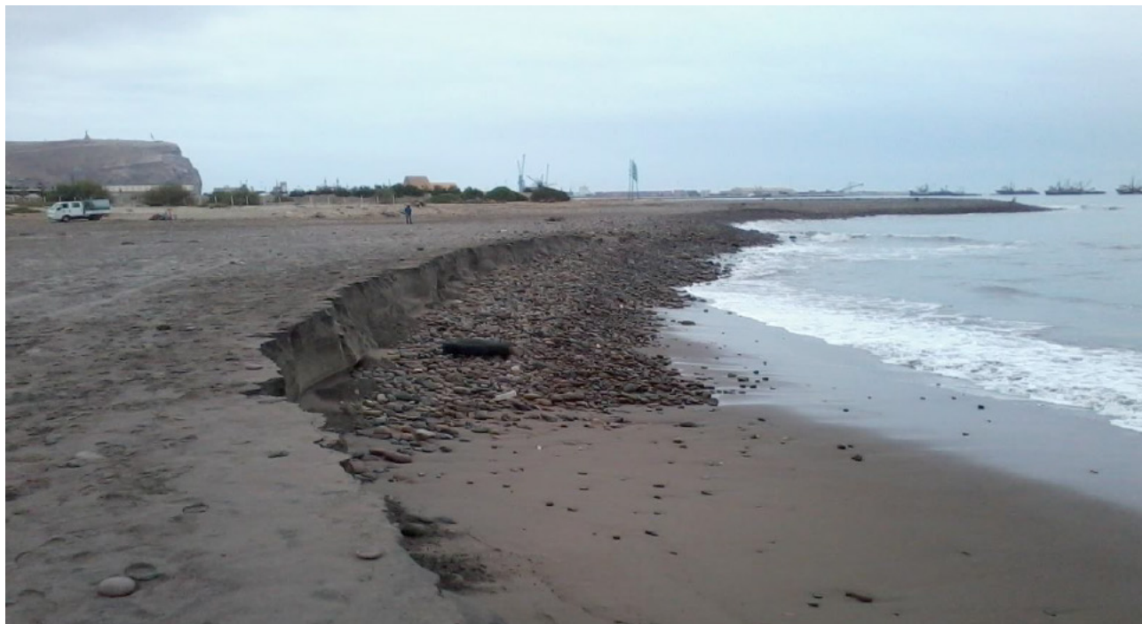
Socavación Playa Chinchorro, 7 Septiembre 2011. Fuente: www.aricaacaballo.com
