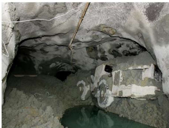
Imagen 7: Bombeo de mineral tipo Barro nivel de producción Mina Regimiento Octubre 2007.
