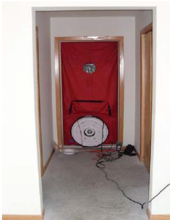
Figura 5-1: Equipo ventilador para realizar un Blower Door Test.
