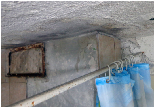
Figura 46: Deterioro al interior de viviendas Condominio Comandante Canales
