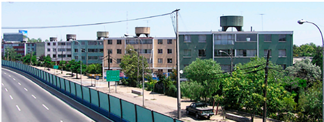
Figura 36: Bloques de Pob. Juan Antonio Ríos aledaños a Panamericana Norte
