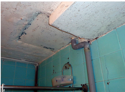
Figura 24: Deterioro por obsolescencia física en Condominios Sociales
