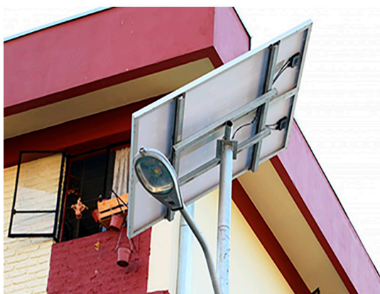
Figura 59: Instalación de farolas solares fotovoltaicas
