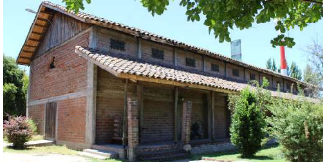
Fig 86. Vista exterior bodega crianza vinos. Fuente: Archivo Propio
