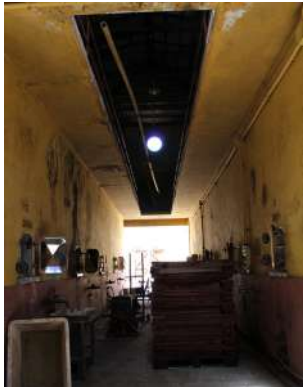
Fig 84. Vista interior piscinas de fermentación. Fuente: Archivo propio
