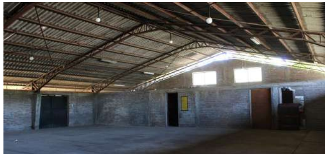
Fig 88. Vista interior extensión bodega. Fuente: Archivo Propio
