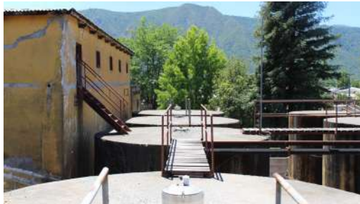
Fig 76. Vista superior planta y cubas. Fuente: Archivo propio.
