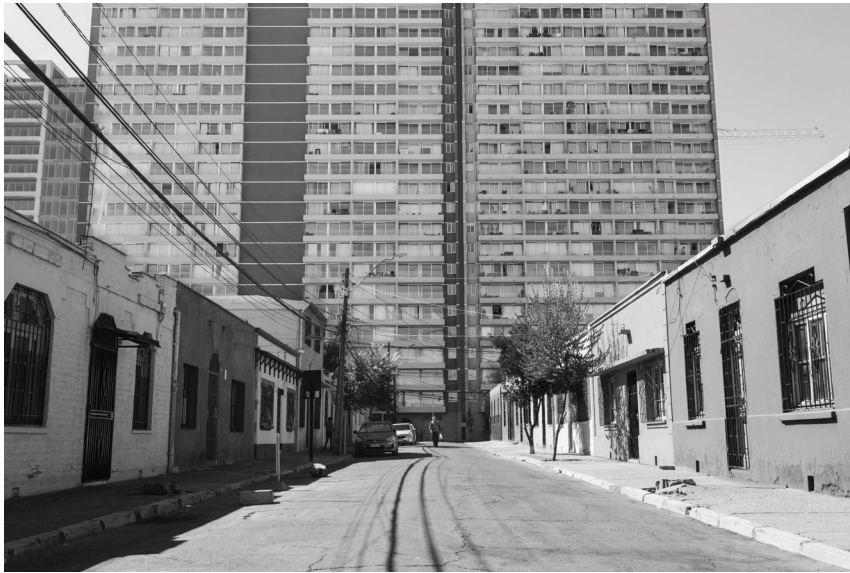
Imagen 1. Guettos Verticales en Estación Central. Fuente: lanacion.cl
