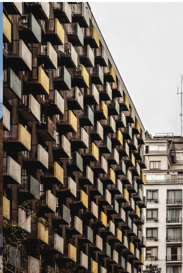
Imagen 9. Edificio Huérfanos 1373. Arquitectos: Jaime Larrain + Osvaldo Larrain + Roberto Muller + Jaime Rodríguez. Año: 1964. Dirección: Huérfanos 1373, Santiago. Recuperado de: http://www.aoa.cl/
