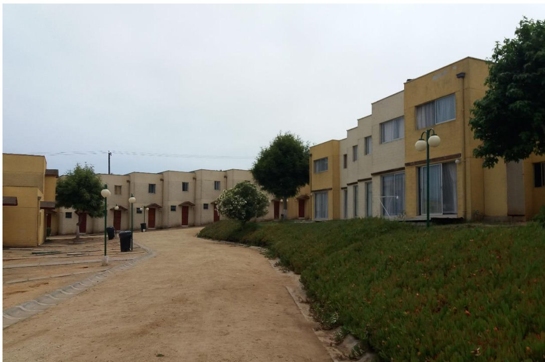
ILUSTRACIÓN 11: EXTERIOR DE LOS DEPARTAMENTOS
