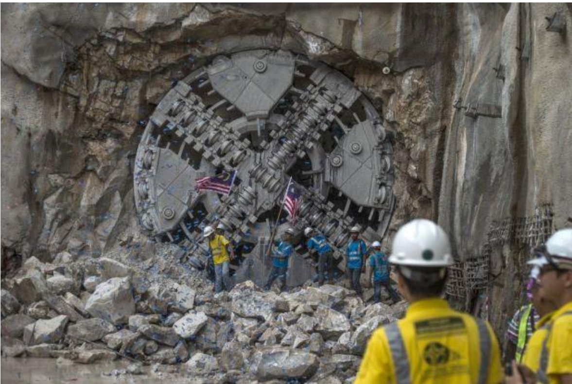
Figura 2-5 Tunelera Cochrane 2, fabricada por Herrenknecht, completa un túnel en Malasia.
