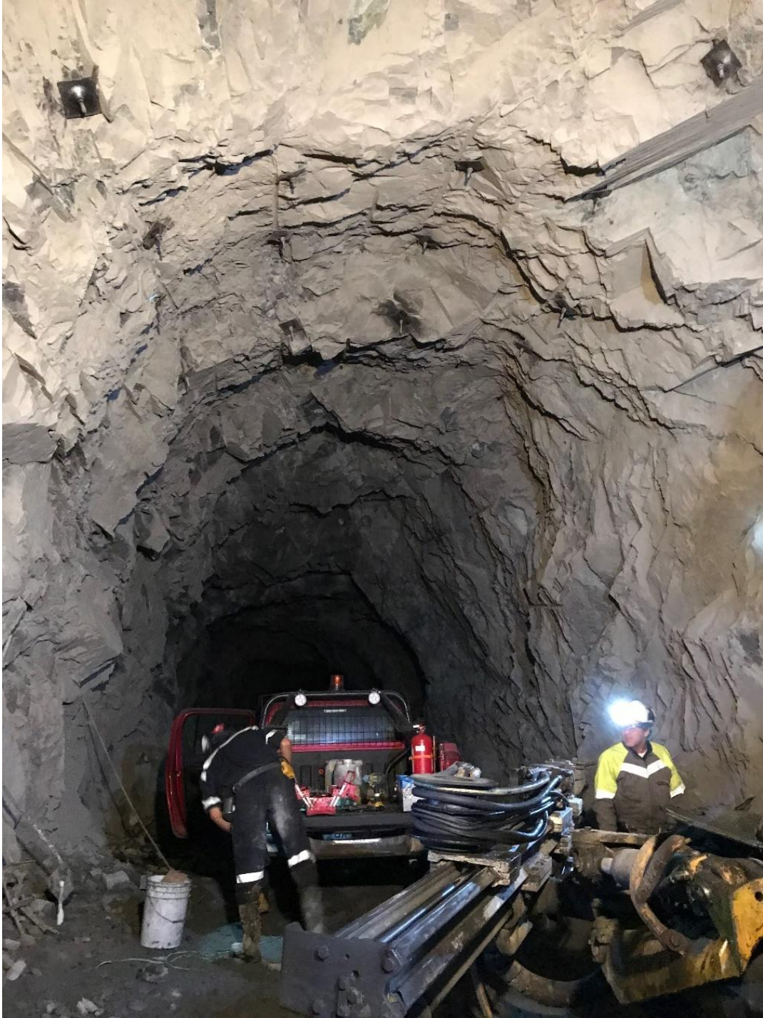
Figura 6-1 Galería sobre excavada en mina Cabildo, (230-4).
