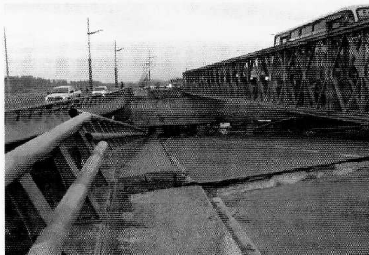
Imagen 10: Puente sobre el Biobío, abril de 2010.
