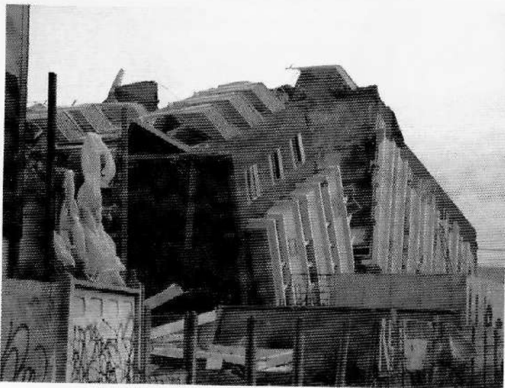
Imagen 9: Edificio Alto Río, Concepción, abril de 2010.
