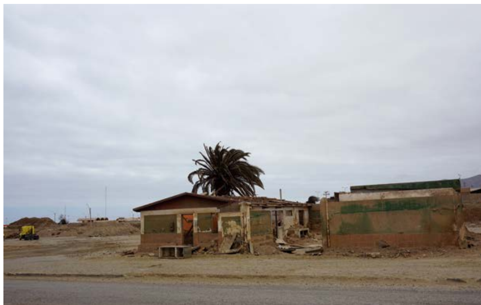
Figura 7. Nivel del barro tras aluviones, Chañaral.
