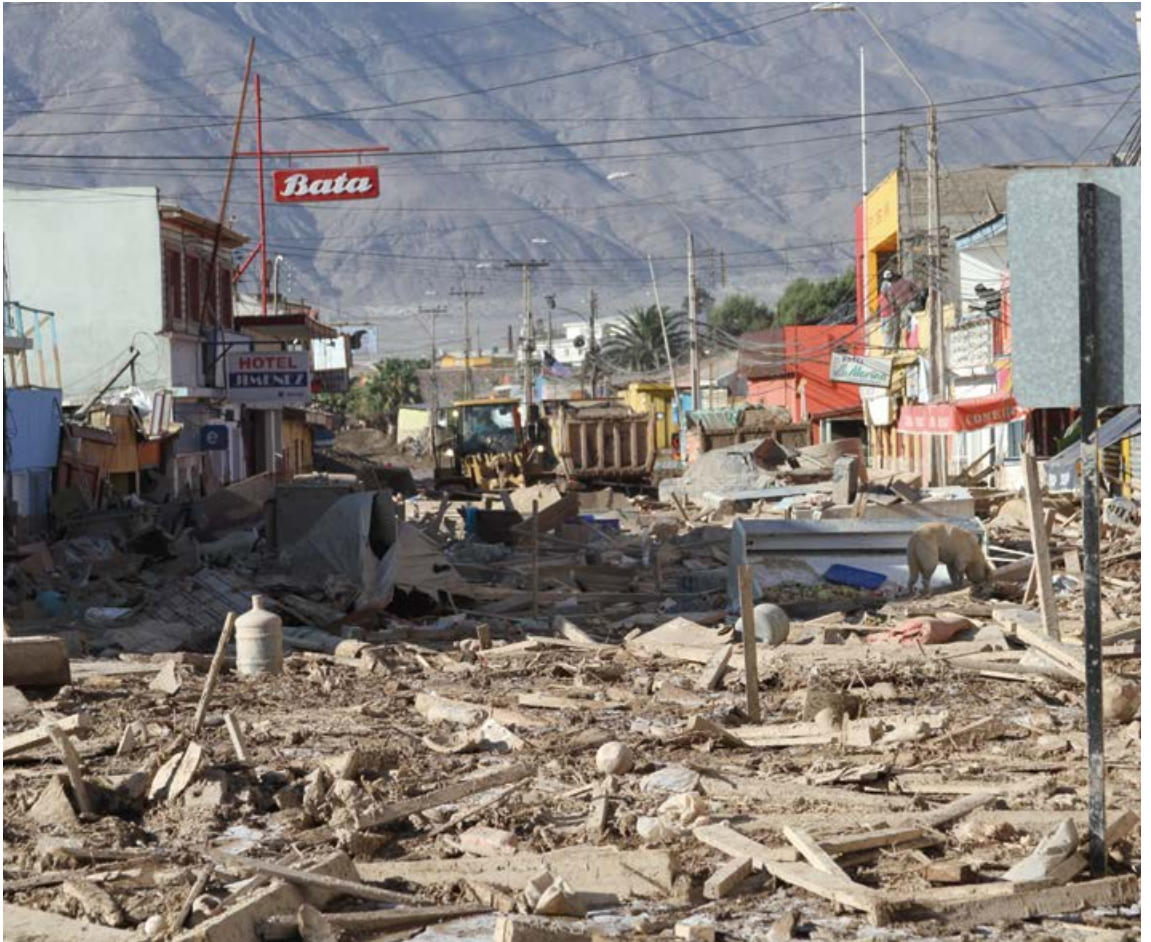
Fotografía tomada el 28 de marzo en el sector del centro, calle Merino Jarpa. Muestra labores de despeje y limpieza de escombros.
