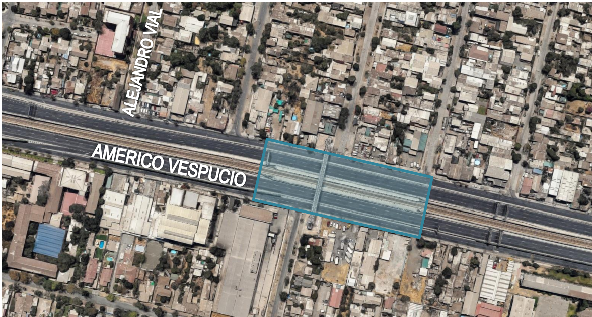
Imagen 106: Vista Aérea Estación Futura de METRO (Obra Gruesa)
