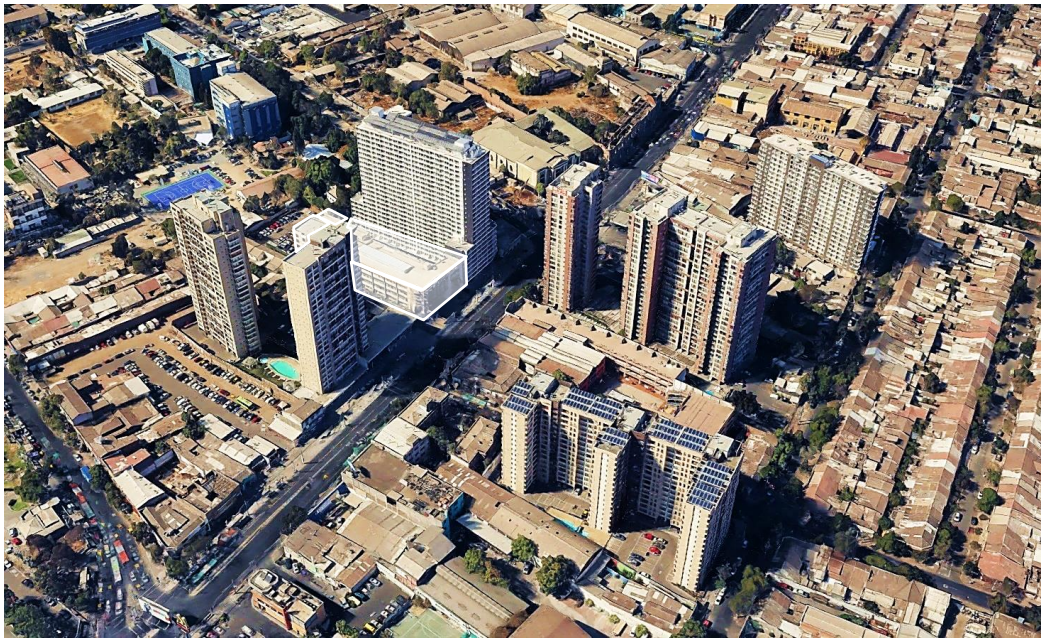
Imagen 15: Edificio Consistorial Municipalidad de Independencia
