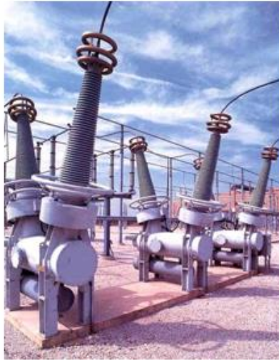
Ilustración 10 Interruptores en Subestación
