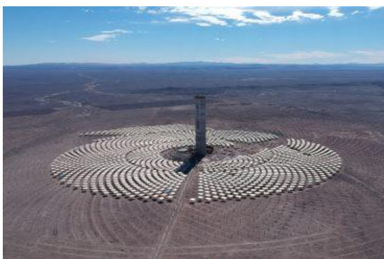
Figura 8: Torre de concentración Complejo Solar Cerro Dominador [9]
