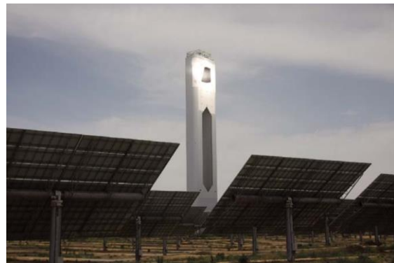
Figura 19: Receptor solar de cavidad [15]
