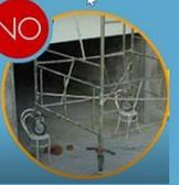
Se pueden usar bases o apoyos para aumentar la altura disponible o firmeza para el desplazamiento de los andamios móviles. Para esto siempre se deben revisar las especificaciones del fabricante.
