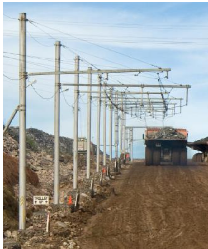
Ilustración 2: Sistema Trolley Assist. catenarias, postes y levadizos
