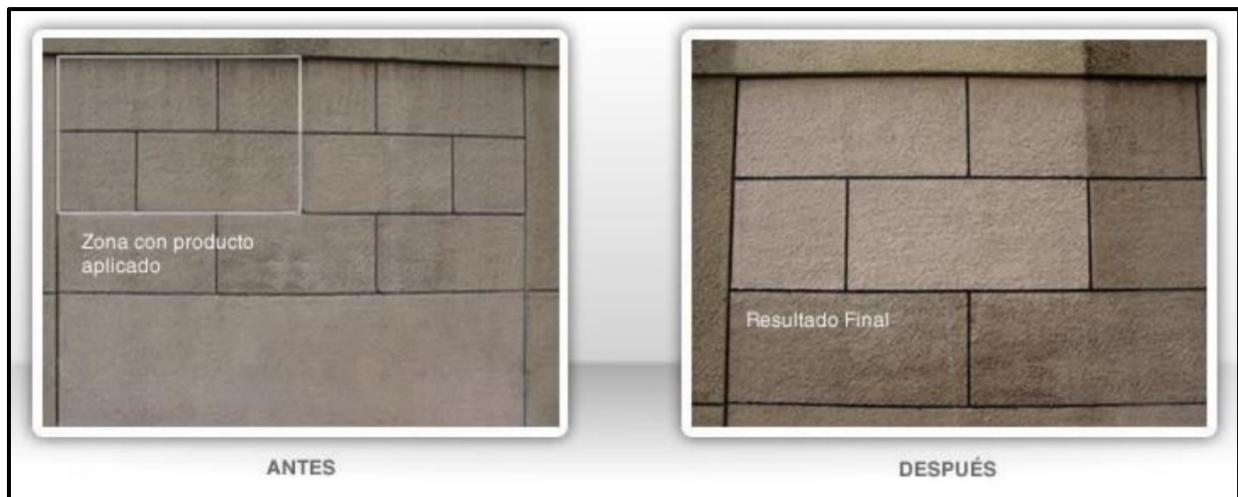
Figura 6. Recubrimiento autolimpiante basado en nanopartículas de \text{TiO}_2 depositado sobre una fachada formada por bloques de mortero [23].
