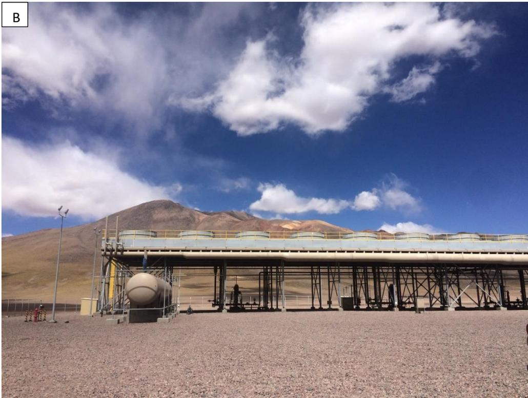
Figura 18b: Fotografía de sistema de enfriamiento de isopentano de la planta geotérmica Cerro Pabellón.
