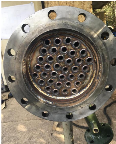
Figura 10.64 Soldadura intercambiador Fuente: Elaboración propia.
