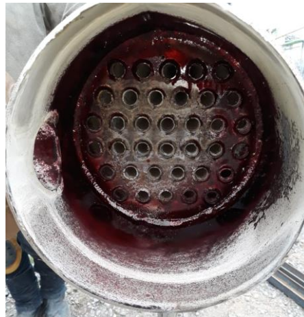
Figura 10.55 Ensayo de tintas penetrantes. Fuente: Elaboración propia.
