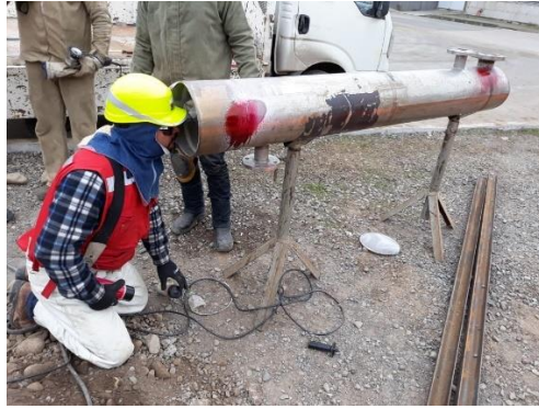
Figura 10.56 Proceso de reparación. Fuente: Elaboración propia.
