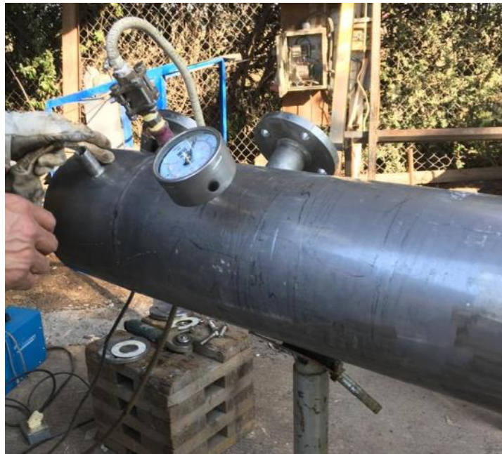
Figura 10.19 Pruebas de presión. Fuente: Elaboración propia.
