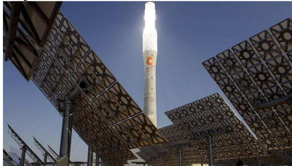
Figura 8: Heliostatos en planta Torresol, España. Fuente: Torresol Energy.
