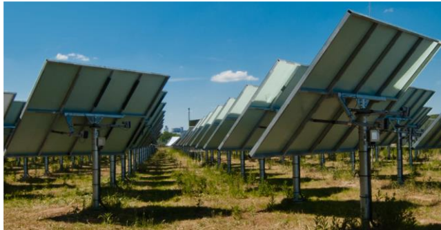
Figura 7: Heliostatos en planta experimental de Julich, Alemania. Fuente: Planta Julich.
