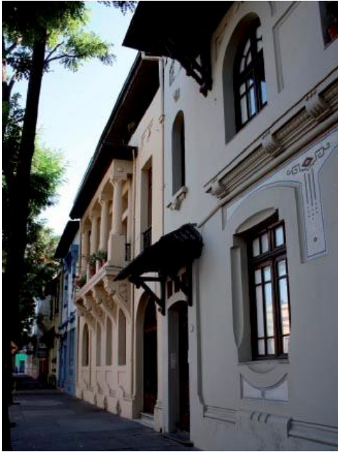
Fachadas bien conservadas e integradas en calle Maipú.
