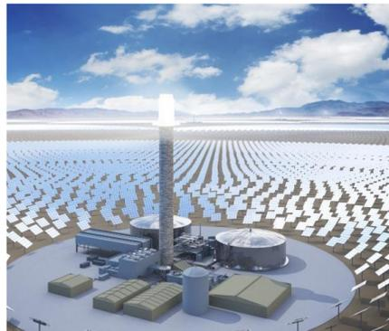
**Figura 4:** Modelo de planta de CSP de torre con sales fundidas. Fuente: SolarReserve
