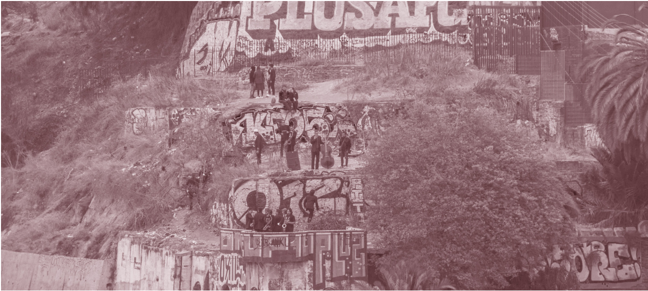
3. Vista de las ruinas de la calle Aquiles Reed desde el Paseo Dimalow, Cerro Alegre. (En el momento que se realizaba una presentación de músicos en el lugar.)
