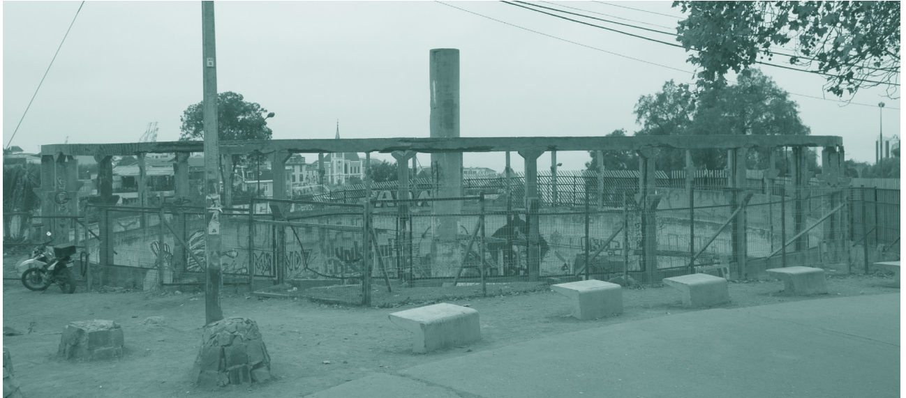
6. Ruinas del estanque de Agua, vista desde la Calle Aquiles Reed, desde la salida norte del PCdV.
