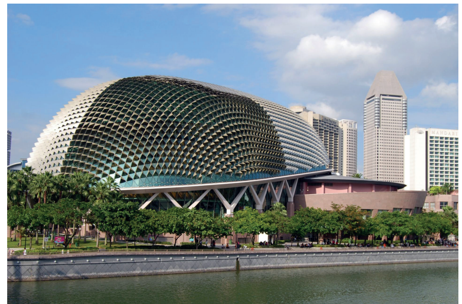
Imágenes 3 y 4. Ejemplo de Diseño Biomimético en la piel paramétrica de The Esplanade - Theatres on the Bay, Marina Bay, Singapore, basado en la geometría del durian, un fruto tropical típico de la zona. (arriba) interior de la obra (abajo) exterior de la obra Fuente: DP Architects
