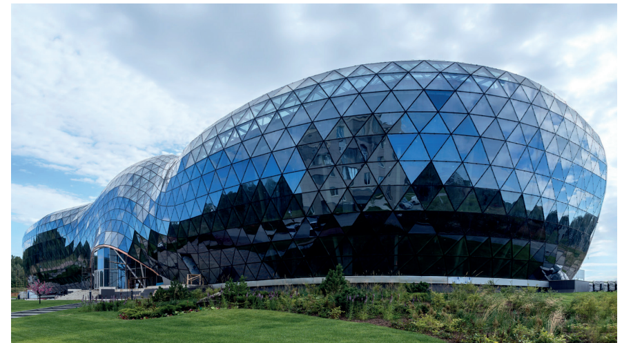
Imagen 39. Bio-TechnoPark en Novosibirsk, Rusia. Estrategia: Delaunay Triangulation Fuente: Web de Graitec
