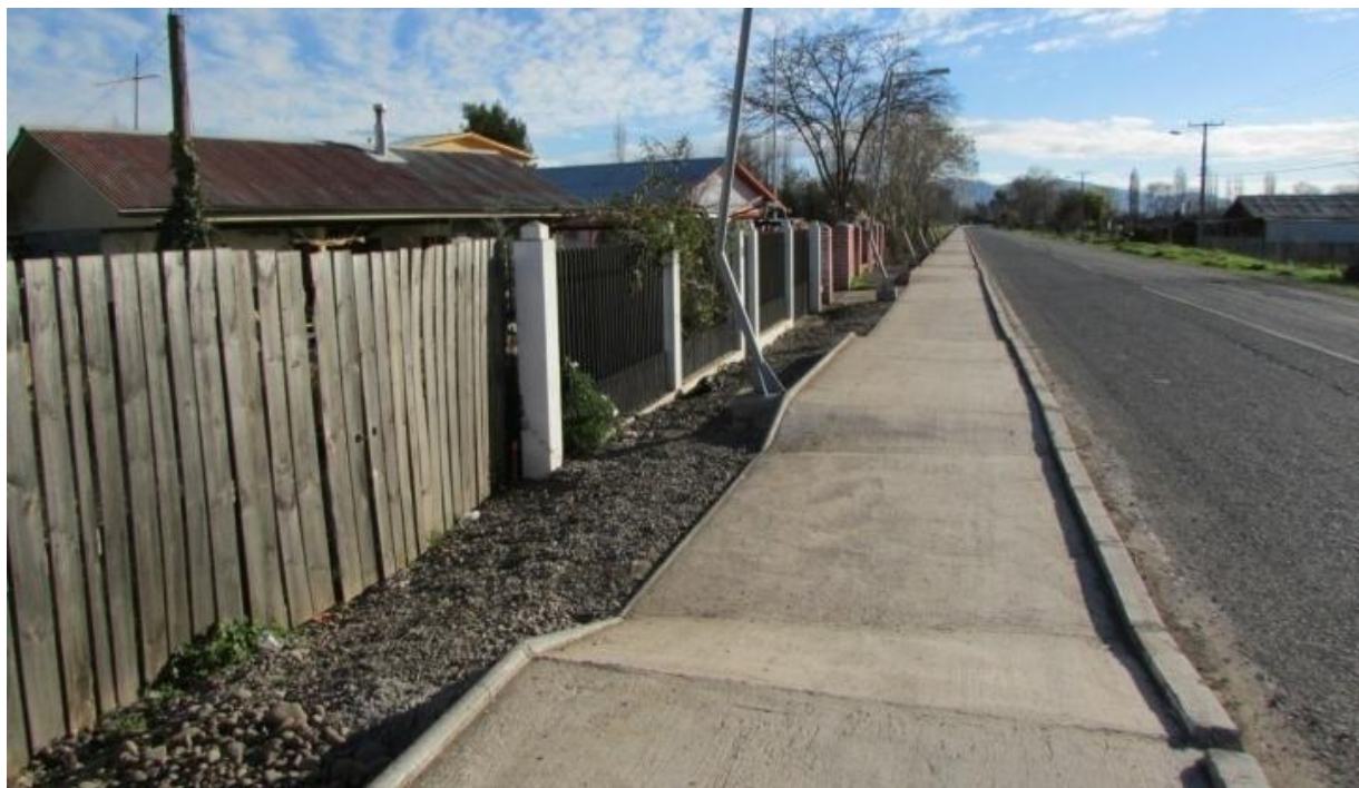
Figura 30: Ciclovías fragmentadas por los accesos a las viviendas, tránsito interrumpido, la bicicleta vibra, haciéndose peligroso e incómodo para el ciclista.
