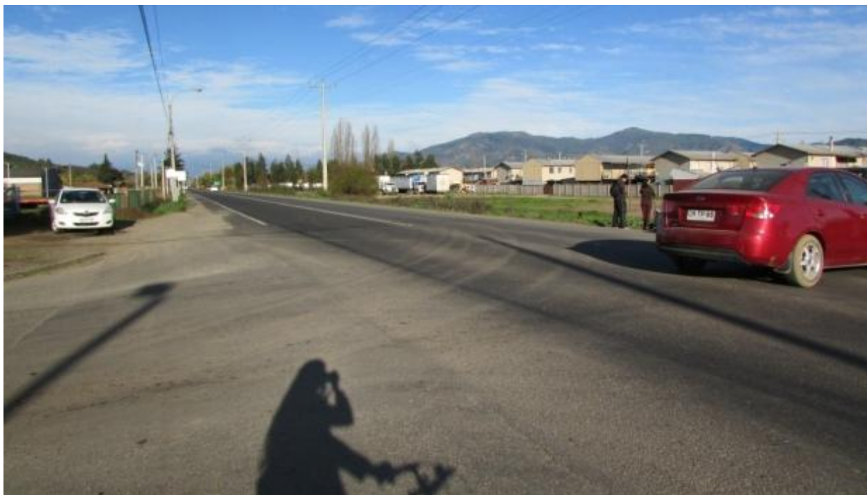
Figura 35: Carretera de la Fruta que divide Pueblo de Indios con el centro de San Vicente, no hay atravesos demarcados, constituyéndose en un cruce peligroso.
