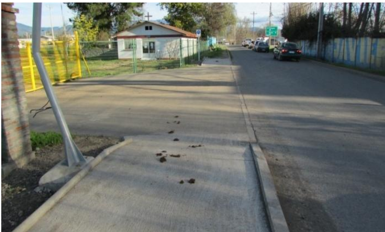
Figura 29: Al ser usada por caballos, la ciclovía presenta suciedad en su superficie, lo que interfiere con el libre tránsito de los ciclistas.
