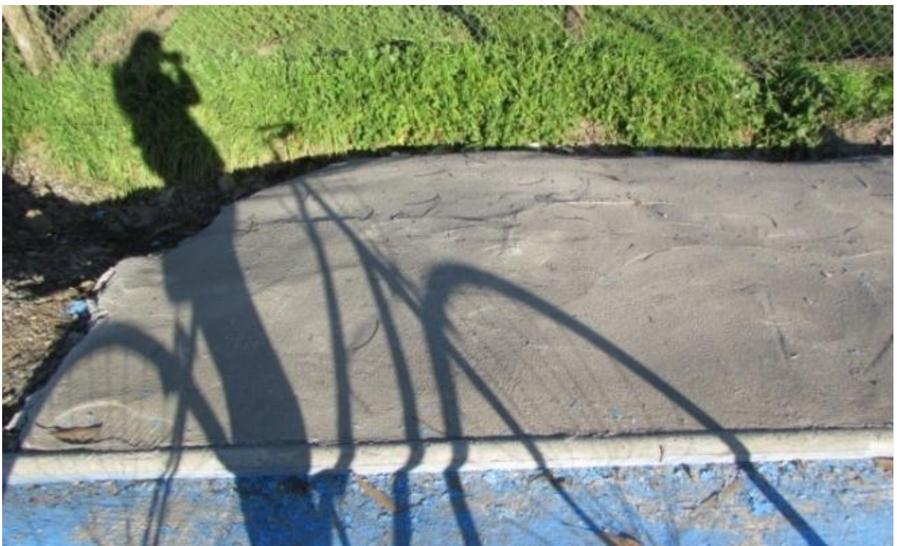
Figura 34: Peligrosa zanja al costado de la ciclovía.
