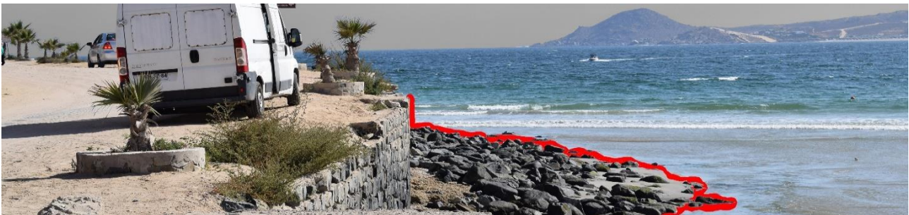
“Costanera sector de la península, lado norte, vista hacia muro rompeolas. Este sector presenta como fortaleza la construcción de un muro de aproximadamente 2,5 metros de altura”.
