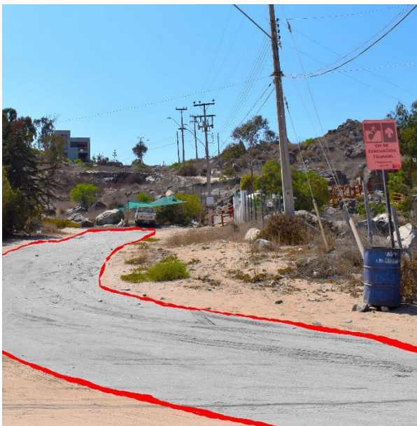
“Vía de evacuación desde sector oriente de la península, se observa calle identificada con señalética, que no permite un avance superior a 200 metros”
