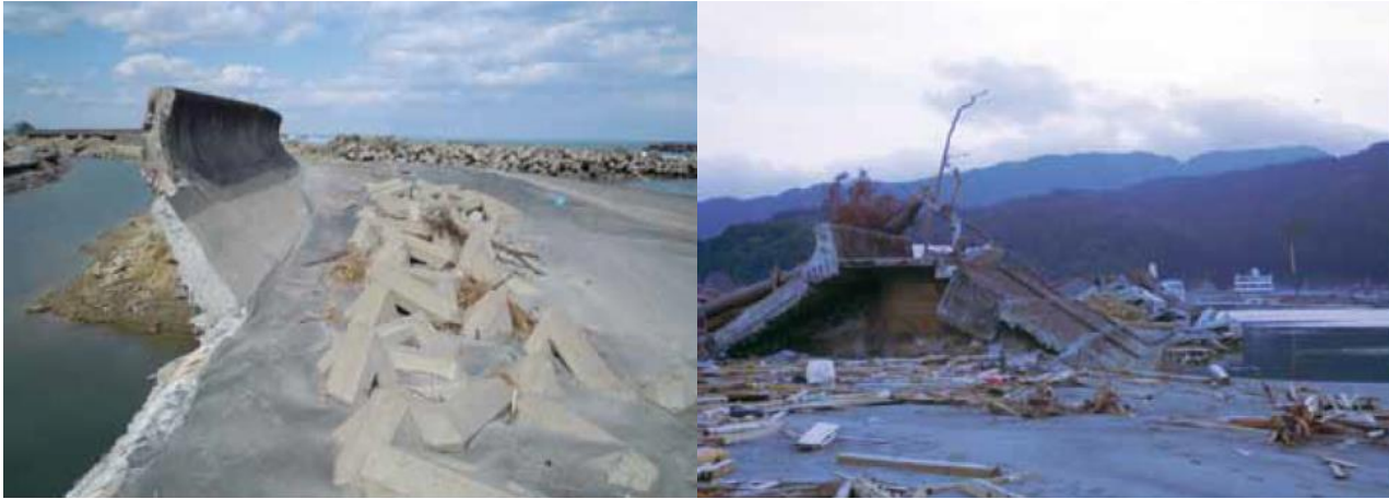
IMAGEN 11: IZQUIERDA: RUPTURA DE LAS ESTRUCTURAS DE DEFENSA EN WATARI. DERECHA: ÚNICO ÁRBOL DEL BOSQUE COSTERO DE MITIGACIÓN DE RIKUZENTAKATA, QUE SOPORTÓ EL TSUNAMI. FUENTE: (SHIBAYAMA, ET AL., 2012).
