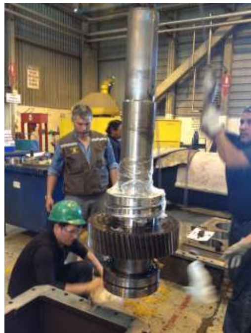
Ilustración 3: Trabajo en terreno.
