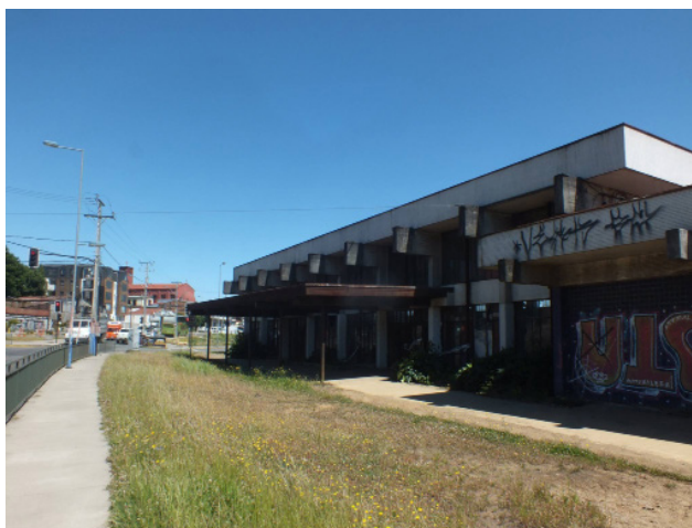
Imagen 20 Ex estación Valdivia
