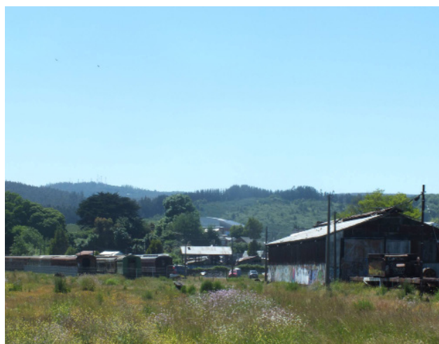
Imagen 21 Máquinas y bodegas de Ex estación Valdivia
