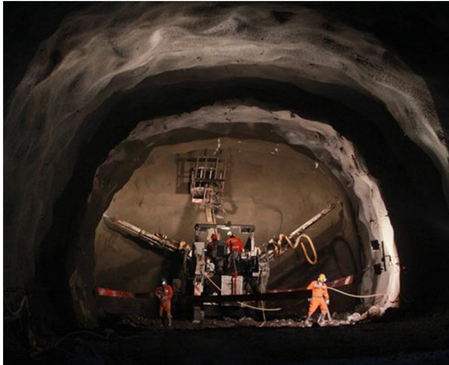
Ilustración 2-7 Jumbo de avance en obras de minería
