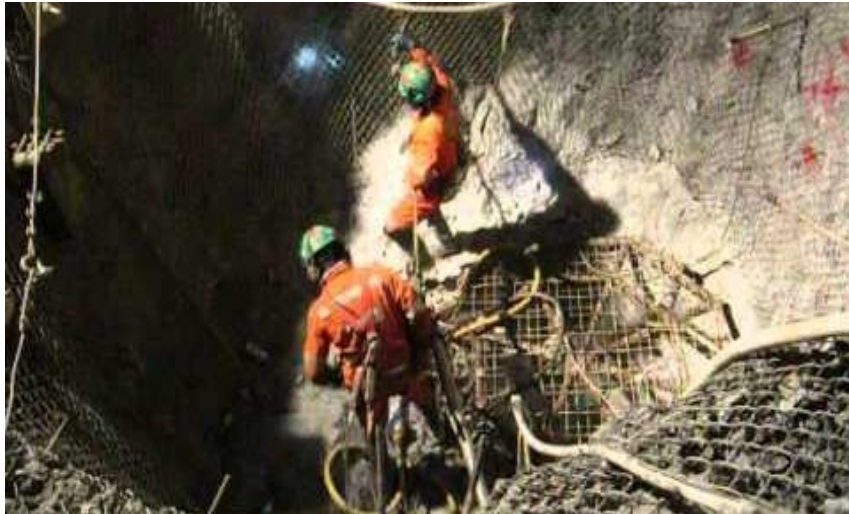
Ilustración 2-9 Trabajo al interior de piques
