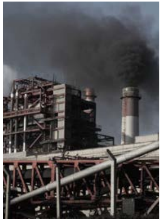
Fig. 1. Pool, C. (2018). CO2 emanado por la Compañía Minera del Pacífico en la comuna de Huasco [Fotografía]. Recuperado de https://twitter.com/clauidiapooldfoto/status/1039272444710866944
