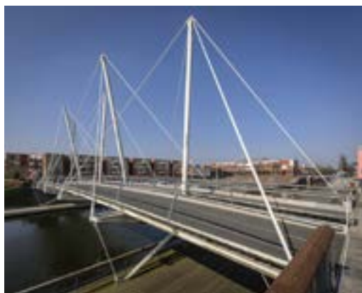
Fig. 95. Puente Almere en Holanda, funcionamiento estructural a través de tensegrity . [Fotografía] Recuperado de http://projects.archiexpo.es/ (2018)
