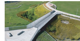
⑪ Puentes Menores
