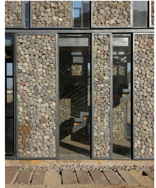
Acceso Parque Met. Sur Polidura Talhouk Arquitectos
