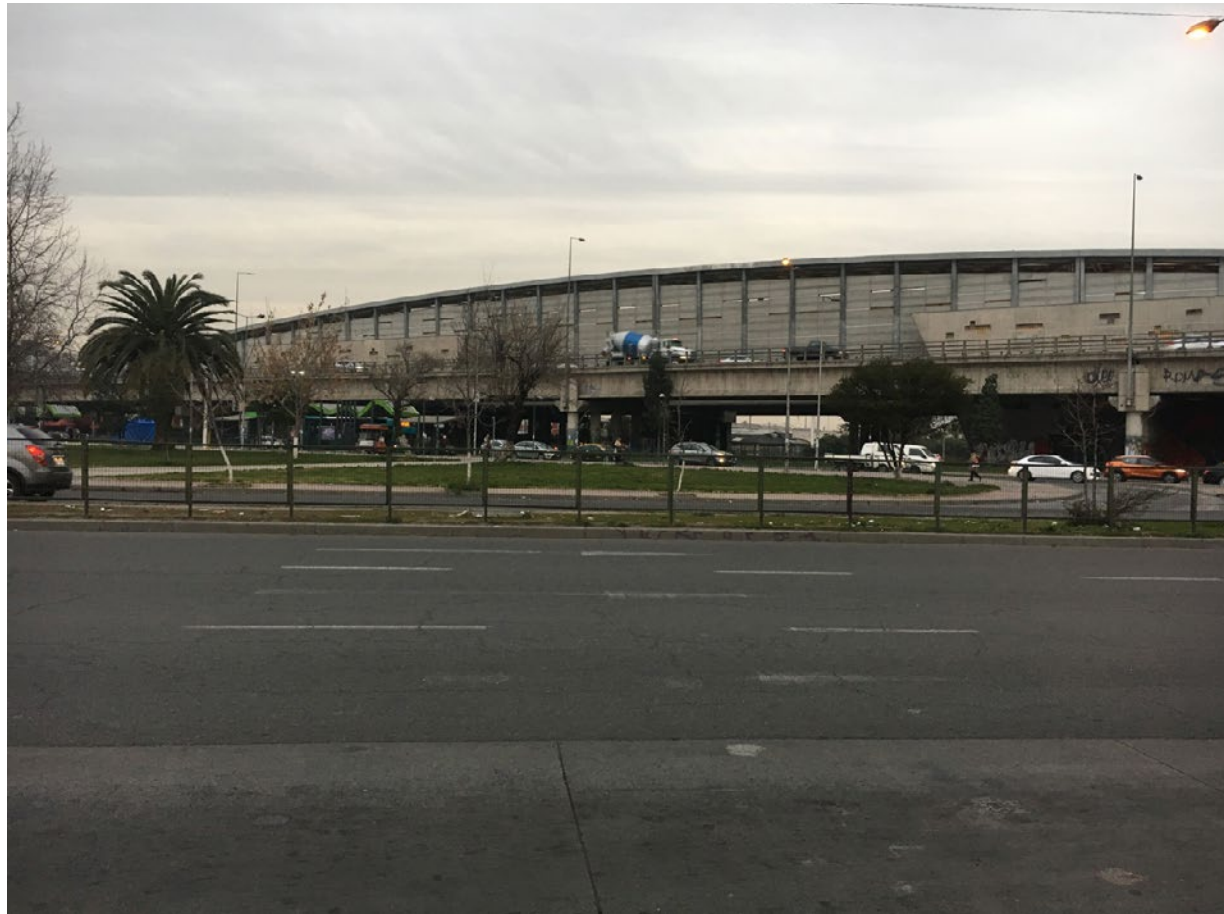
IMG 47. Costado paso superior, vista Av. La Florida. Fotografía propia, 06-08-2018.
