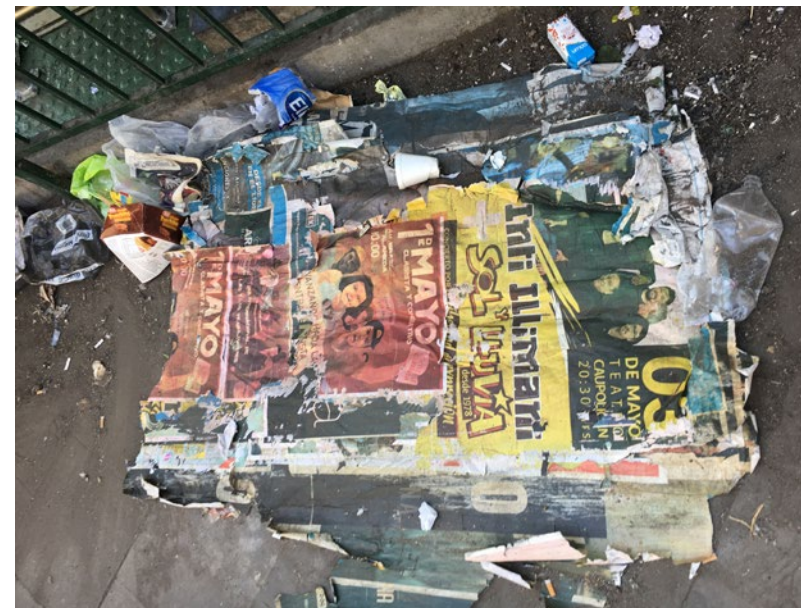
IMG 60. Sección de carteles desprendida del grupo de pilares P03, junto basura que la gente bota a su paso. Sector salida Av. Macul, a un costado del paradero. Fotografía propia, 12-10-2018.
