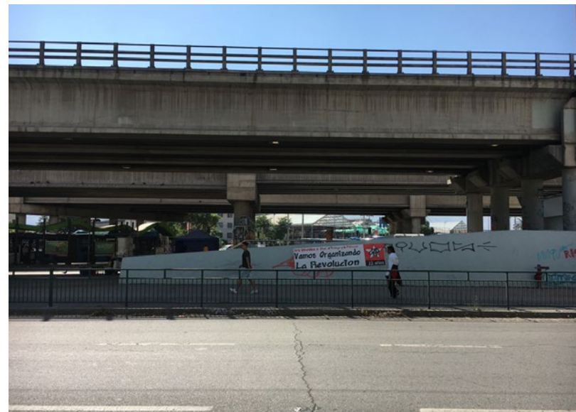
IMG 34. Vista paso superior desde Av. Américo Vespucio. Fotografía propia, 16-11-2018.
