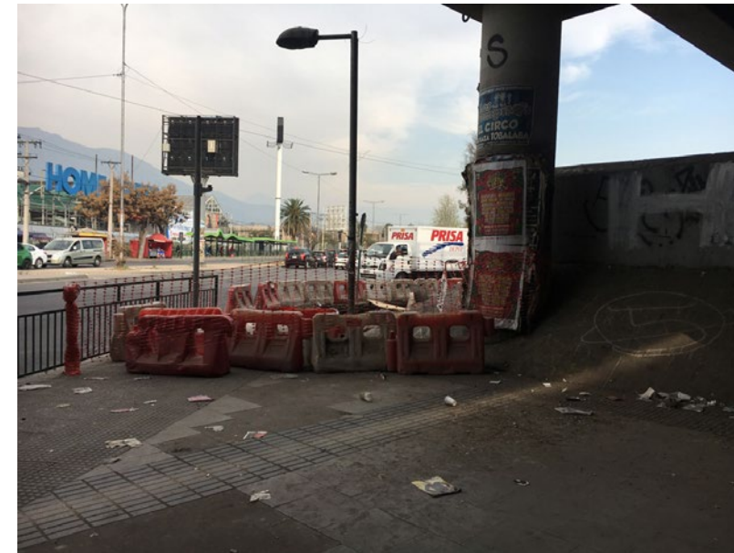
IMG 50. Costado paso superior. Av. Américo Vespucio esq. Av. Macul. Fotografía propia, 12-10-2018.
