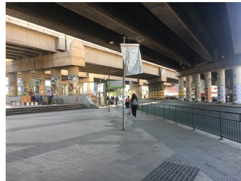
IMG 51. Vista paso superior desde Av. Américo Vespucio. Fotografía propia, 16-11-2018.
