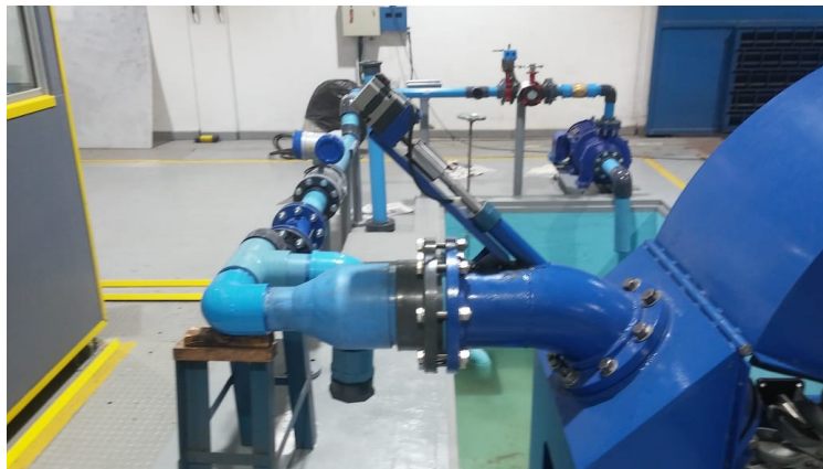
Figura 4.14: Montaje del circuito hidráulico.
