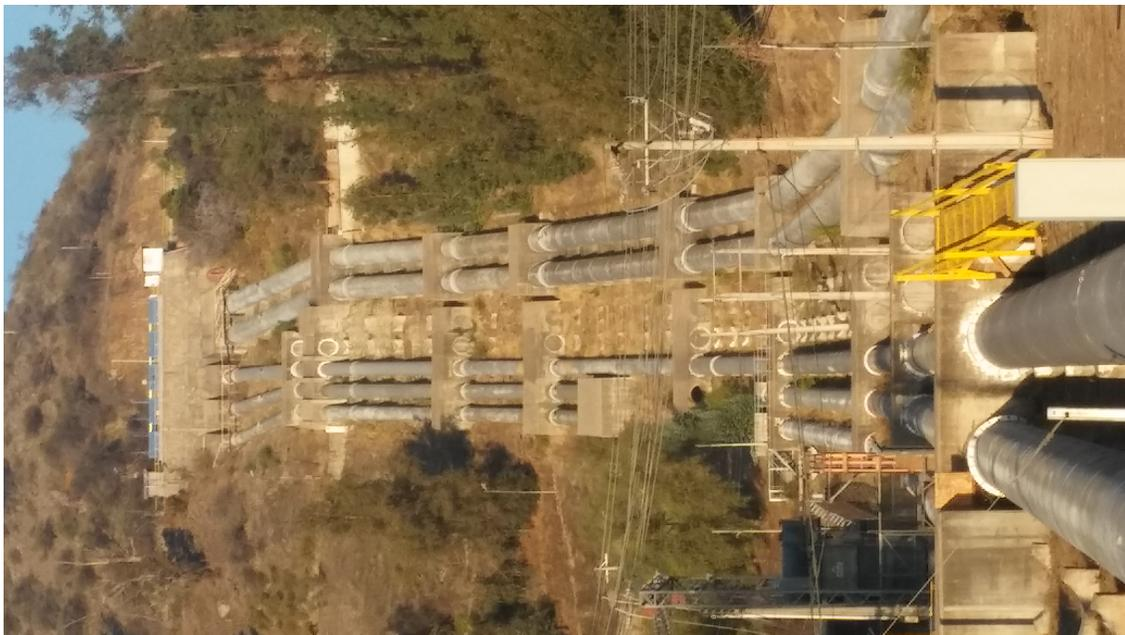
(b) Sistema de aducción desde el bocatoma hacia las turbinas.
