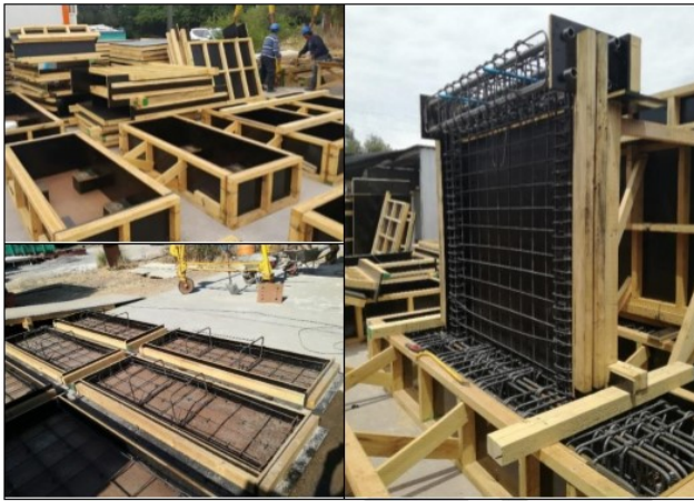
Figura 4.3: Construcción de encofrado y moldaje con enfierradura en su interior. (ACMA, 2018)
