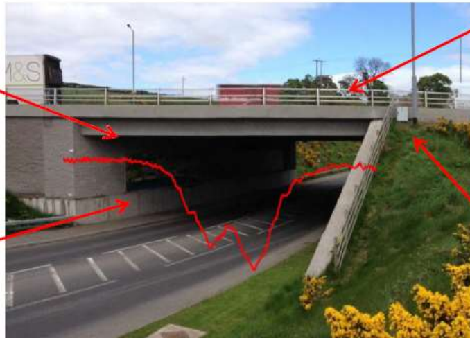
Ilustración B-1: Concepto de B-WIM.
