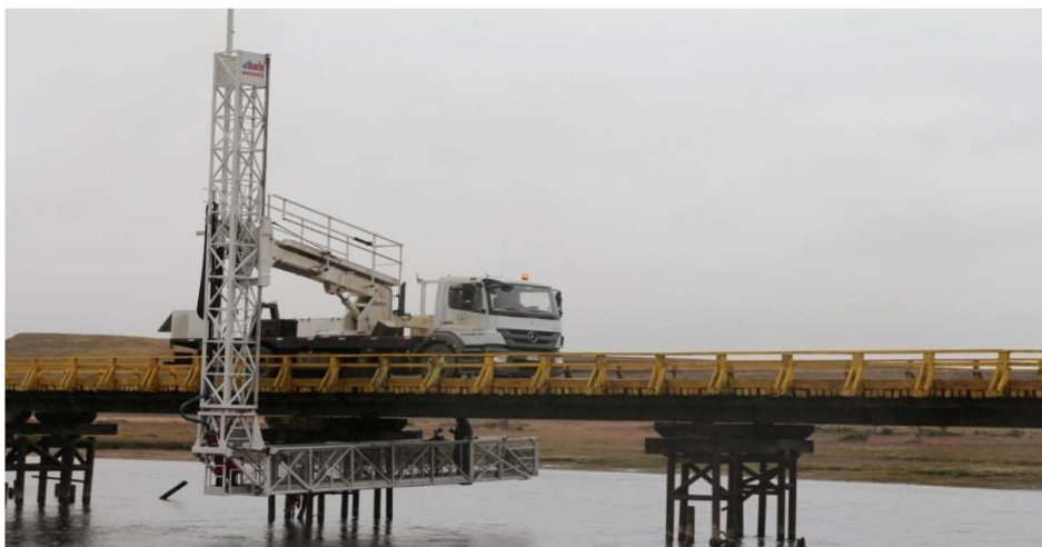
Ilustración 5-3: Camión Inspección MOP (MOP, 2019).
