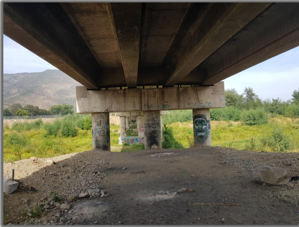
Figura 2-3: Viga de coronamiento, vigas independientes y topes sísmicos puente Águila Norte
