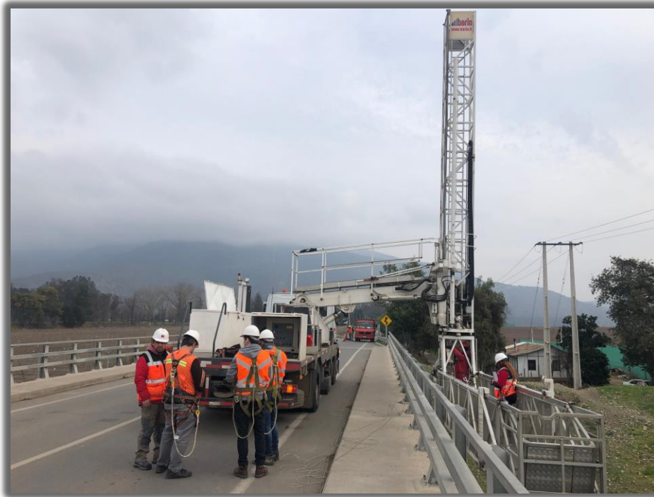
Figura 3-3 Camión de inspección utilizado para la instalación de sensores en las cepas
