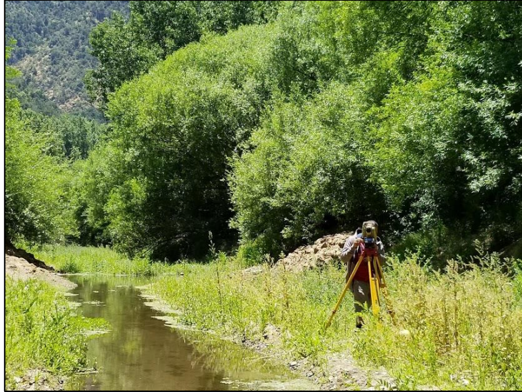
Zona de trabajos topográficos sobre el Estero Pintué. Imagen de estudiantes manipulando la Estación Total. Fotografía propia.
