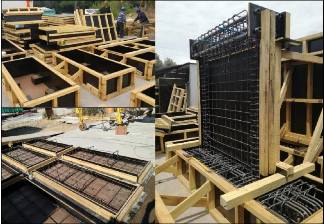
Figura 3.3: Construcción y cierre del moldaje con la armadura en su interior, (Facultad de Ciencias Físicas y Matemáticas, 2018).
