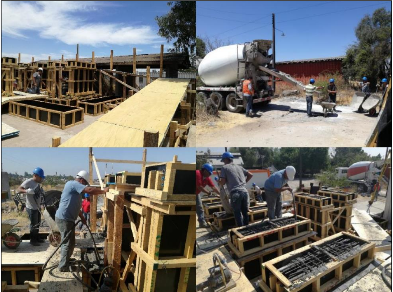
Figura 3.4: Hormigonado de probetas, (Facultad de Ciencias Físicas y Matemáticas, 2018).
