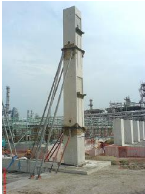
Figura 4. Pilar prefabricado de hormigón armado y sección cuadrada.
