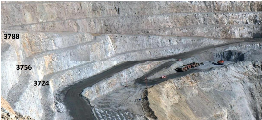
Figura 11: Pared Oeste de la Mina Cielo Abierto.
