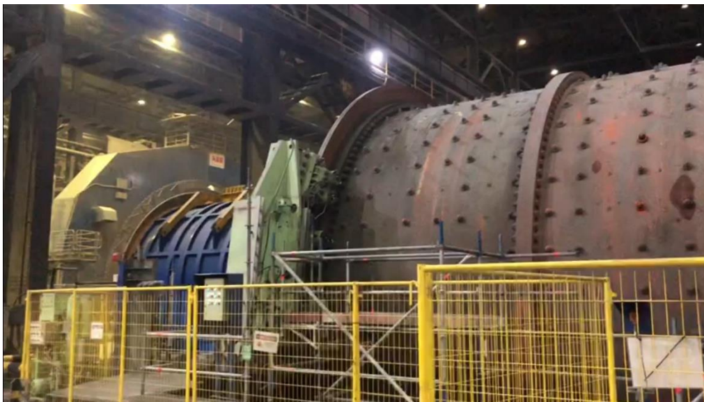
Figura A.31 Instalación de Cierre perimetral y finalización de trabajos.
