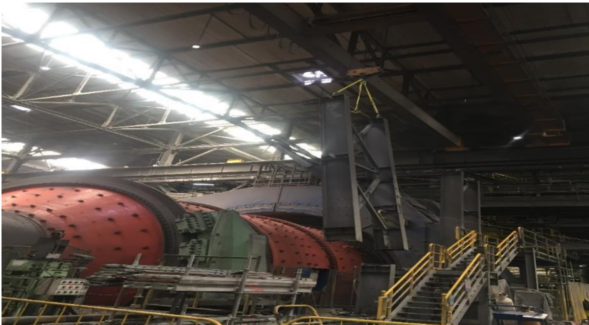
Figura A.1 Inicio de Parada de Planta, desmontaje de estructuras y plataformas
