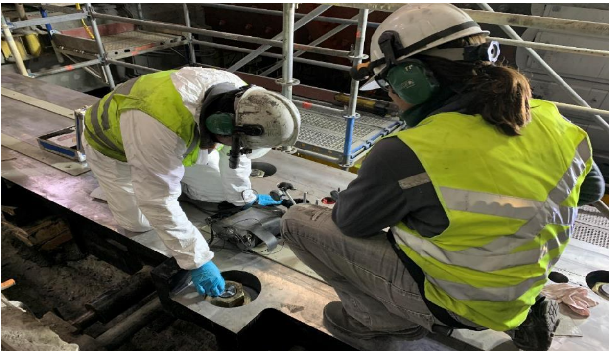
Figura A.19 Montaje, nivelación y torque de pernos de nuevo Soleplate
