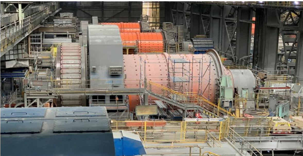
Figura A.9 Posición final estator, para montaje de cáncamos para posterior desmontaje de cuartos de estator
