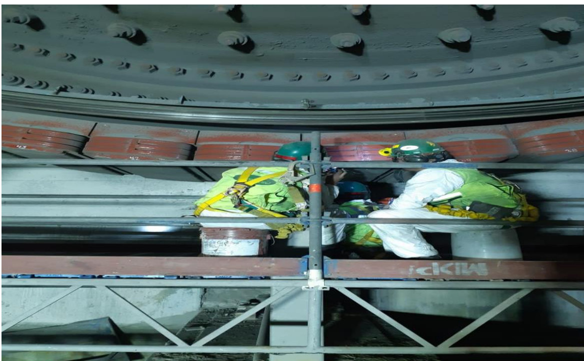
Figura A.13 Preparativos para Desmontaje de Polos
