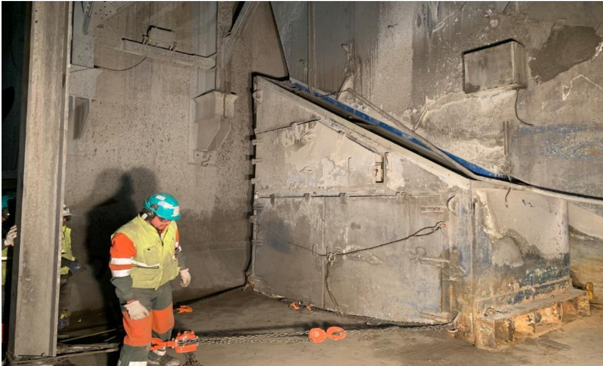
Figura A.6 Desmontaje de Cooling Box
