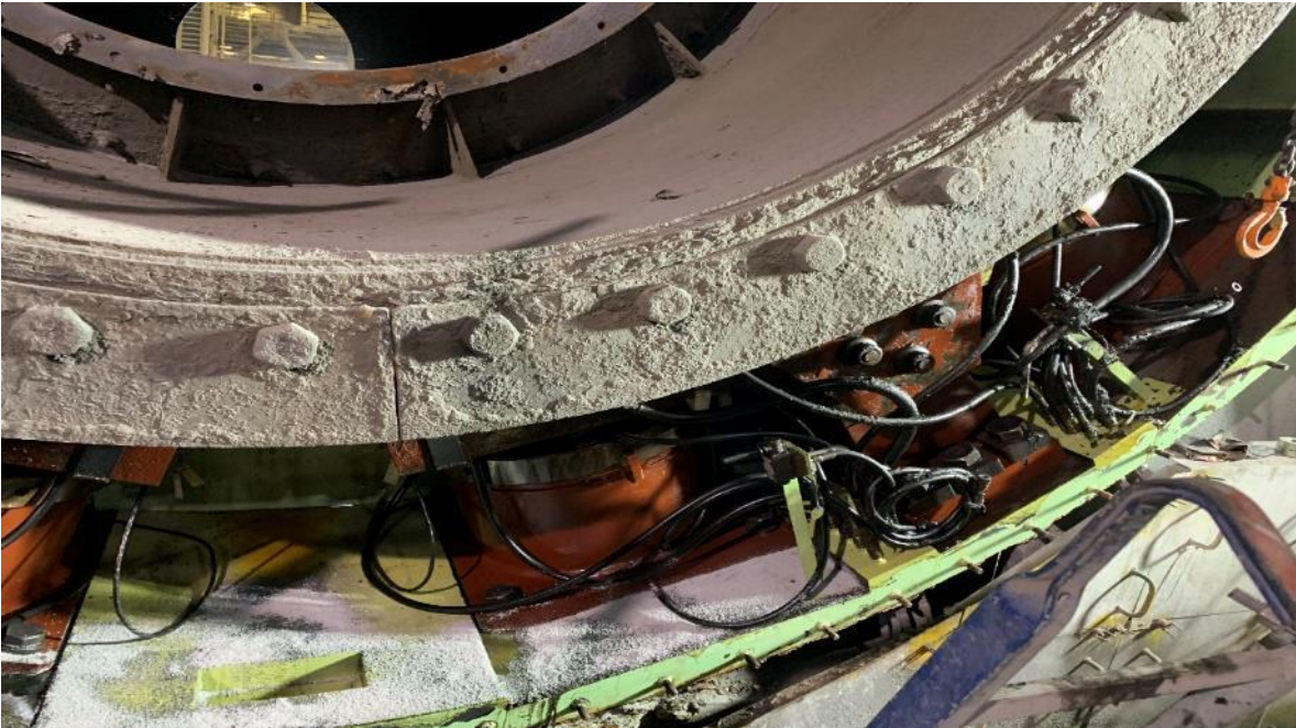
Figura A.16 Desmontaje de pad radiales
