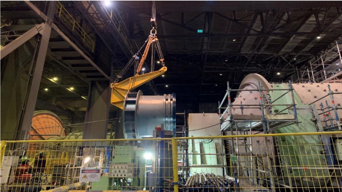
Figura A.26 Montaje y Posicionamiento de Trunnion Liner
