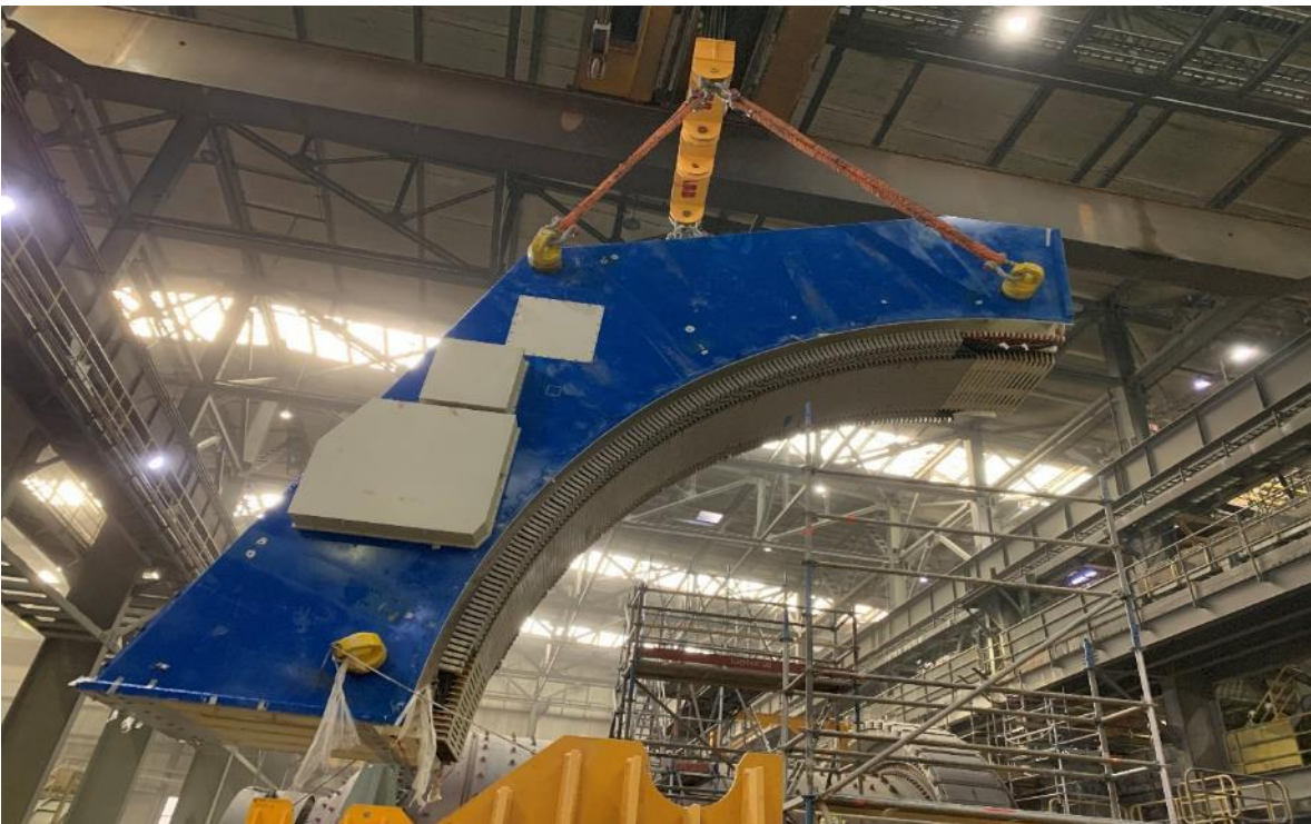
Figura A.23 Izaje y Montaje de los cuartos superiores.
