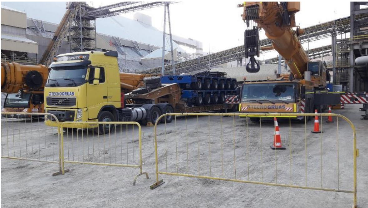
Figura A.3 Instalación de maquinarias para Volteo de cuartos del estator
