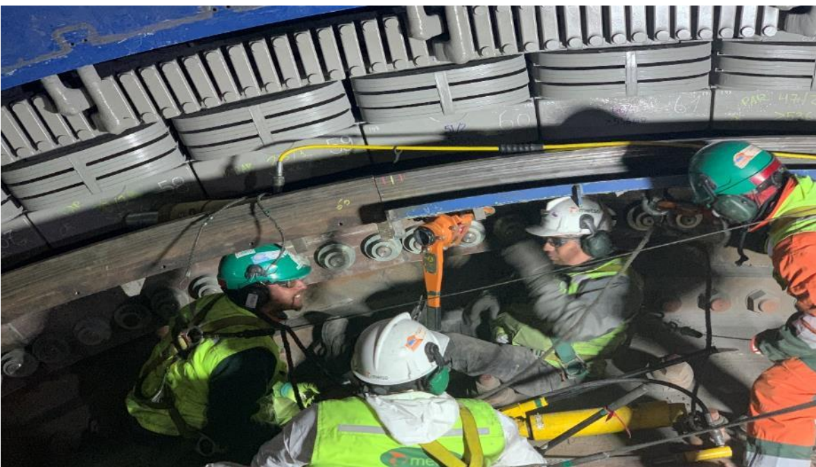
Figura A.27 Alineamiento de Polos y Torque de Pernos Molino.
