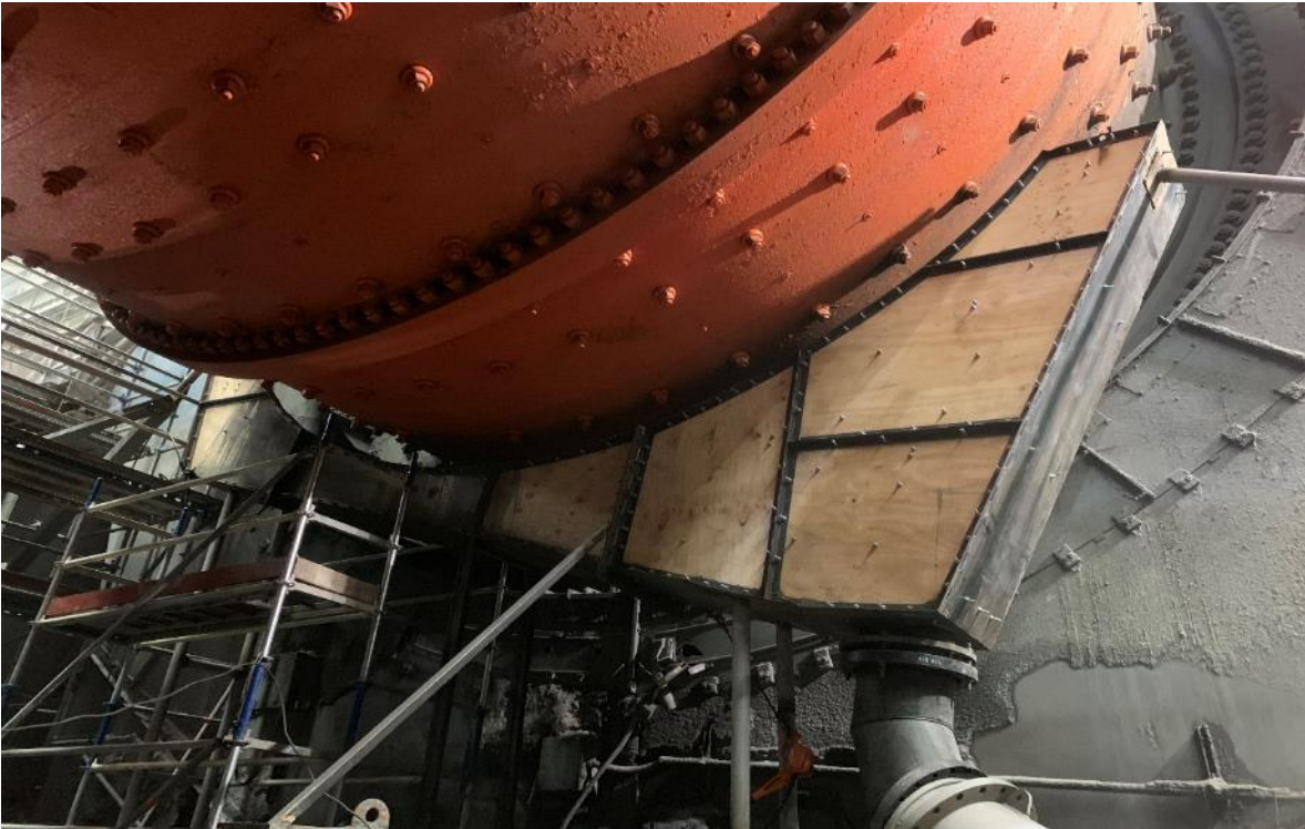
Figura A.4 Instalación de dispositivo para vaciado de bolas Molino
