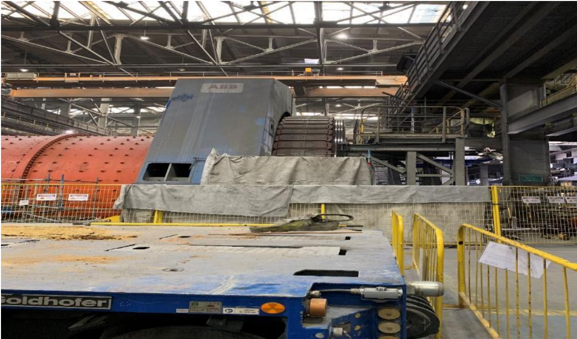
Figura A.8 Desplazamiento de estator a posición de mantenimiento
