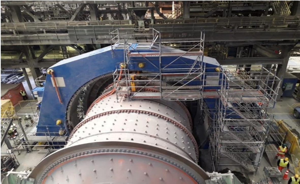
Figura A.24 Finalización de montaje y posicionamiento de Cuartos de Estator.
