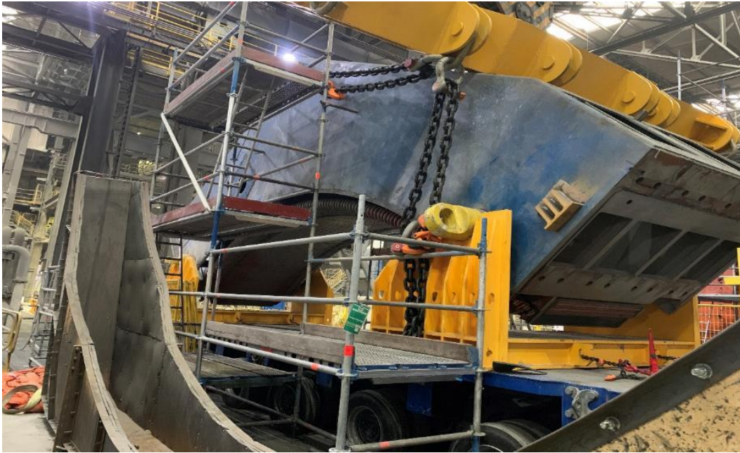
Figura A.10 Desmontaje y Posicionamiento de cuartos para traslado a Patio de Volteo (Grúas)
