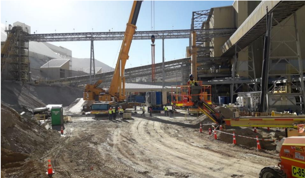
Figura A.21 Izaje y montaje de Cuartos de Estator.
