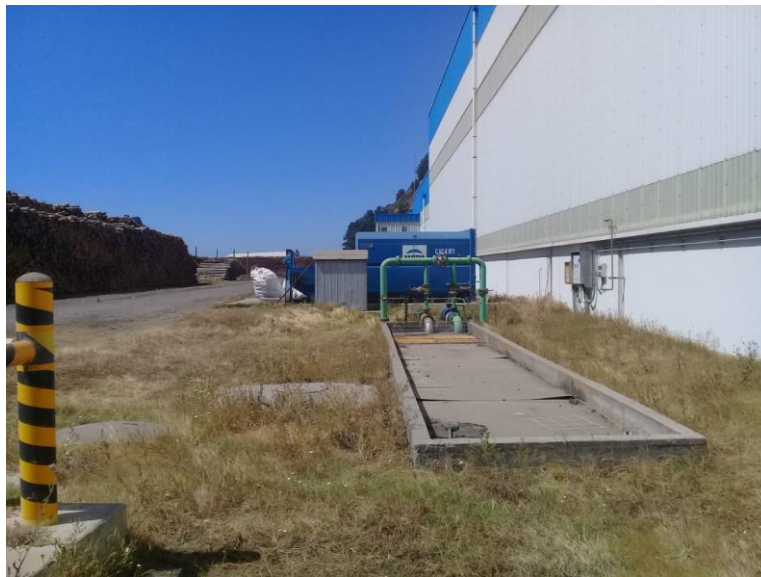
Figura 5.42: Ubicación pozo de recuperación en desuso
