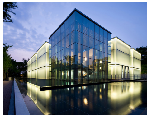
Imagen 76: Edificio en policarbonato
