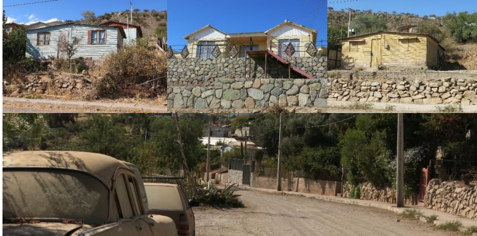
Figura 2.4 Casas y cercos de pircas de la calle que se construyó luego del terremoto. Se ven algunas 'mejoras' (Valle Los Olmos).
