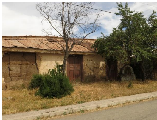
Figura 2.5 Casa abandonada en la Calle Nueva con la Calle de la Cancha (Guzmanes).
