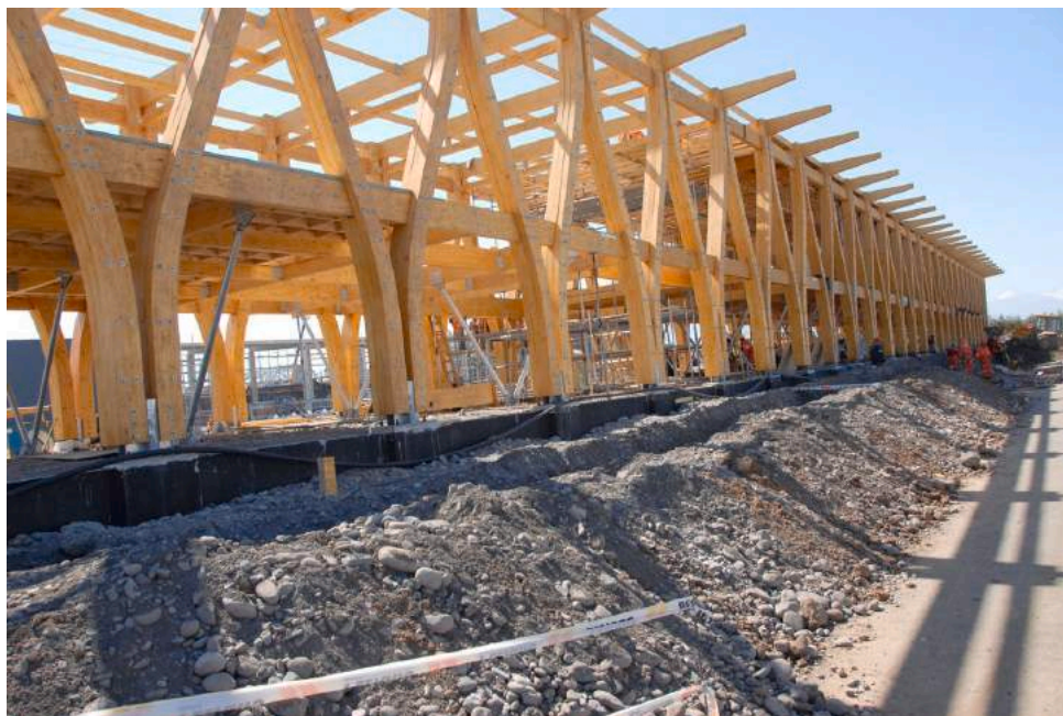
Figura 46: Fachada edificio administrativo en construcción Fuente: Plataforma Arquitectura
