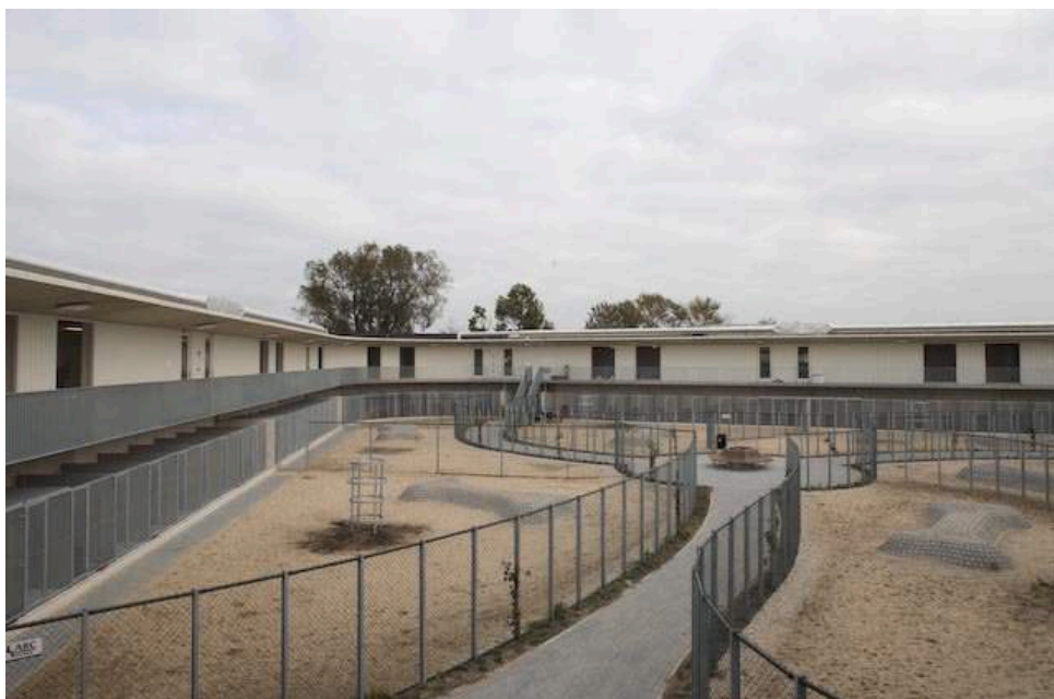
Figura 38: Caniles y sus respectivos patios Fuente: Plataforma Arquitectura
